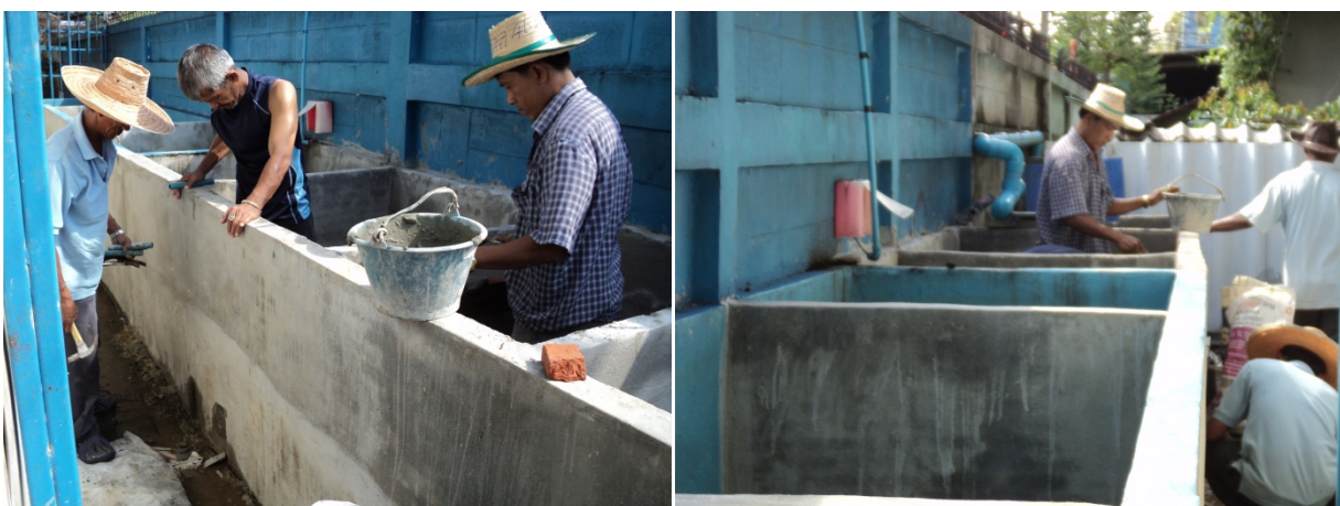
รูปที่ 12 การสร้างระบบบำบัดน้ำเสียแบบบึงประดิษฐ์ของโรงเรียนบางแค (เนื่องสังวาลย์อนุสรณ์)
